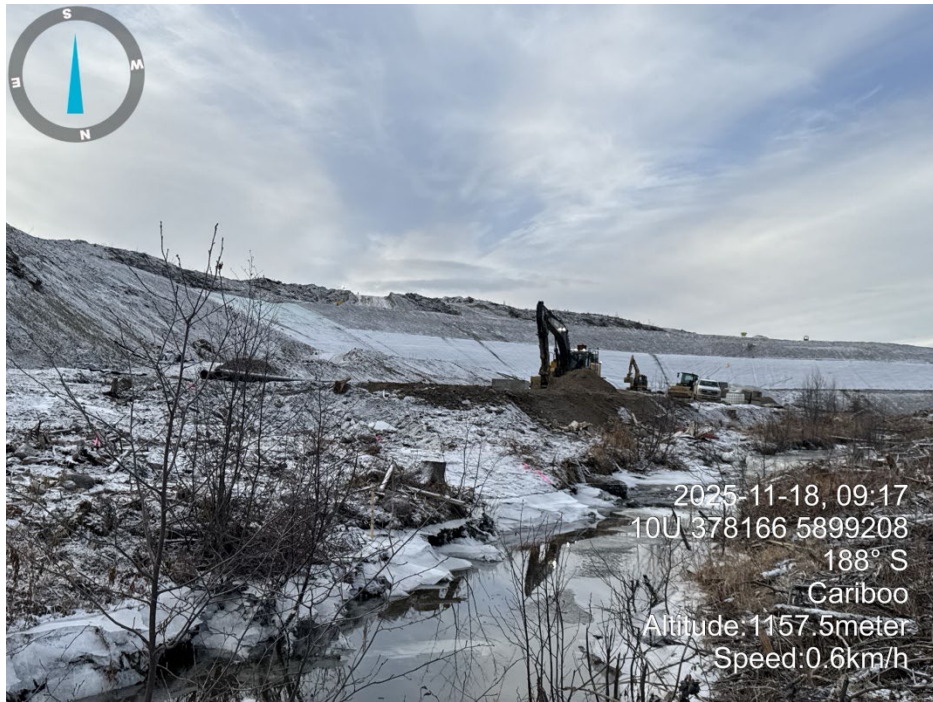
FWR outlet construction
